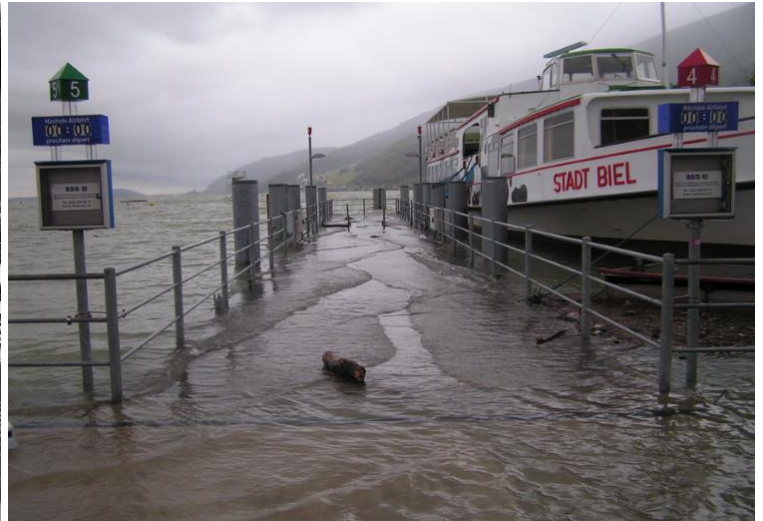
Hochwasser 21.9.2007; Hafen Biel
