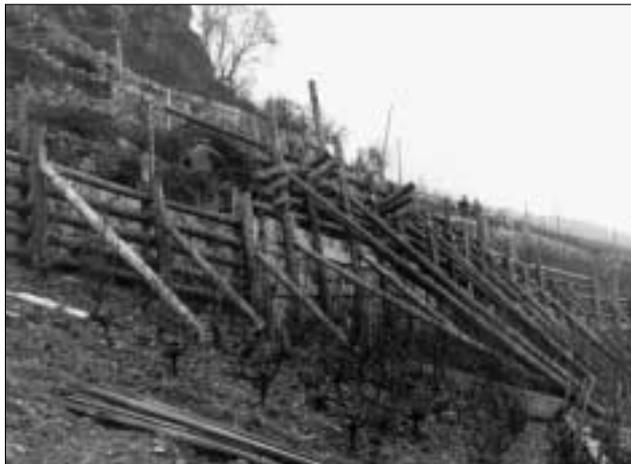
Rochennes: Sicherung alter Rebmauern nach dem «Rutsch».
